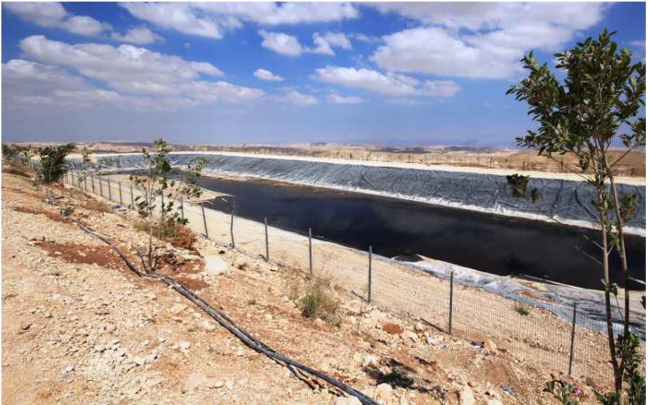
Décharge d'al-Minya : protection des nappes phréatiques par la collecte de lixiviat dans un bassin dédié recouvert d'une géo-membrane
